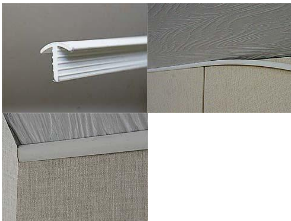
Оформление стыка потолочных и стеновых панелей Isotex Т-образным профилем
