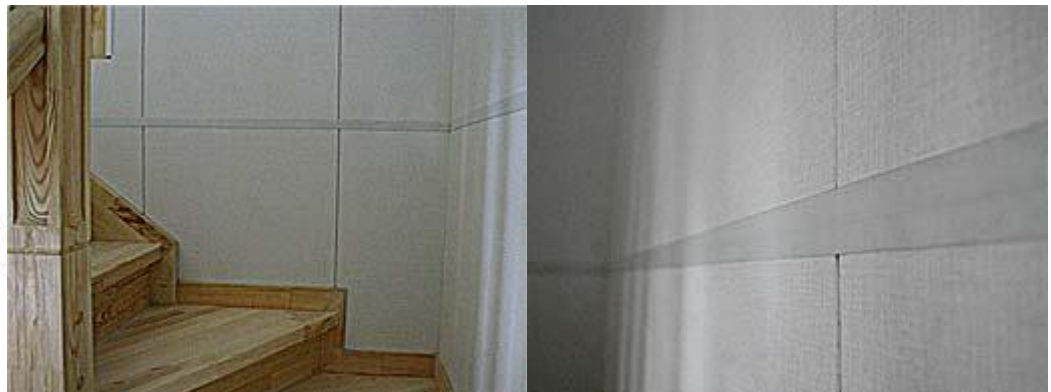
Соединение панелей по высоте
