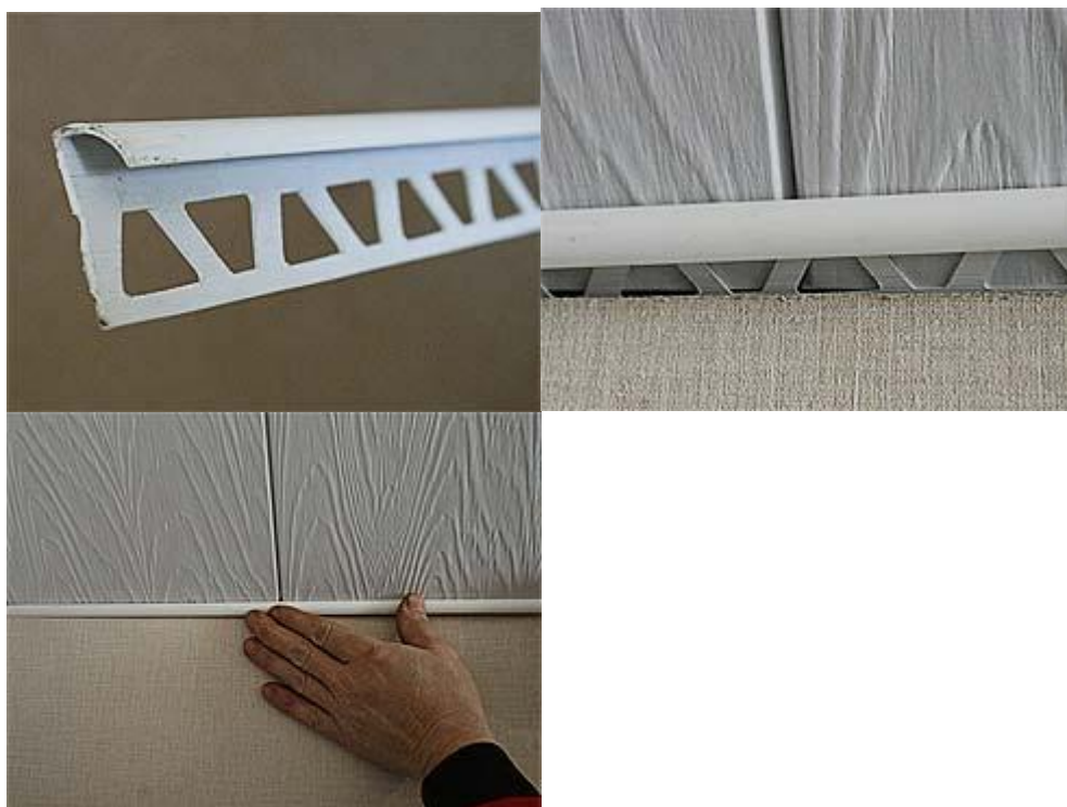
Оформление стыка потолочных и стеновых панелей Isotex Г-образным профилем
